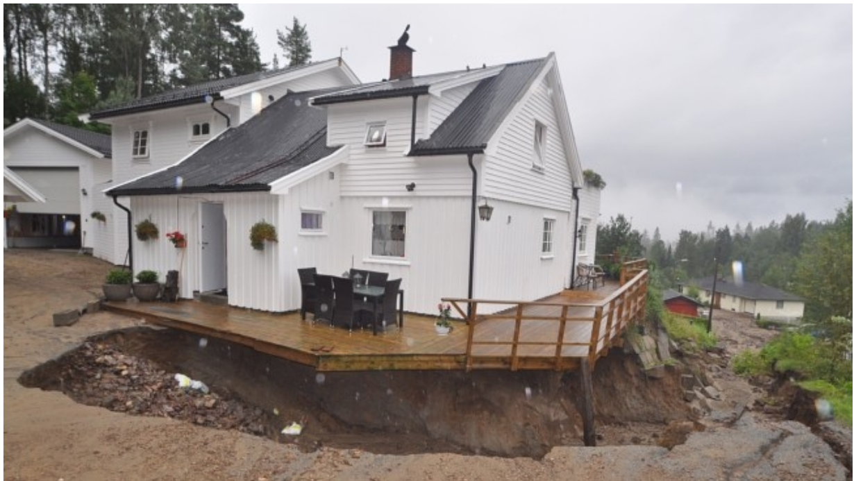
Figur 1.6.7 Fra aftenposten.no: "Forsikringselskapet If anslår at nattens ekstremvær i Vestfold og Buskerud har ført til skader på privat eiendom for 150 millioner kroner". Her et hus i Krokstad som er nær ved å gli ut. Foto: ??
