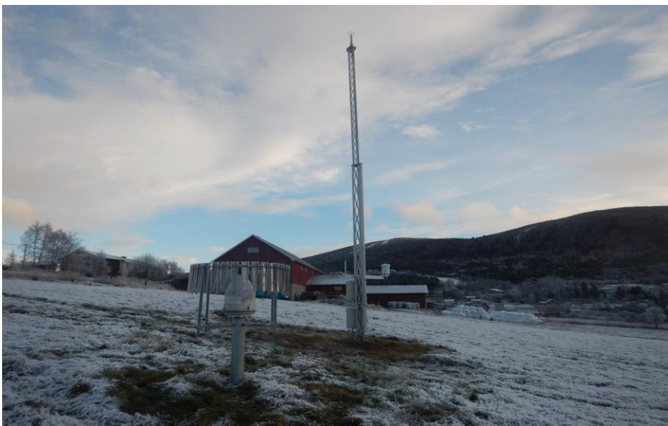
Figur 6 Dombås – Nordigard den 27. november 2018 sett mot E (foto Y. Øen).
