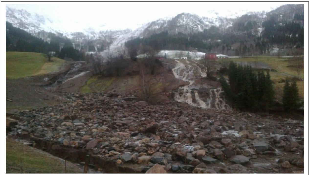
ENORME SKADAR: Rasmassane har gjort store skadar på gardsbruka på Berge.
