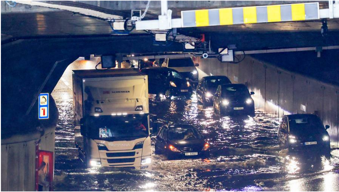
Bilde 1: Baneheitunnelen, som leder E18 gjennom Kristiansand, ble fylt med vann. Foto: Tor Erik Schröder / NTB
