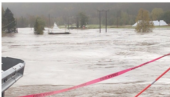
Her sto brua inn til Grøn fjelldalen i Rana før uværet og flommen tok den med seg. FOTO: ELIN IREN STORVOLLENG
