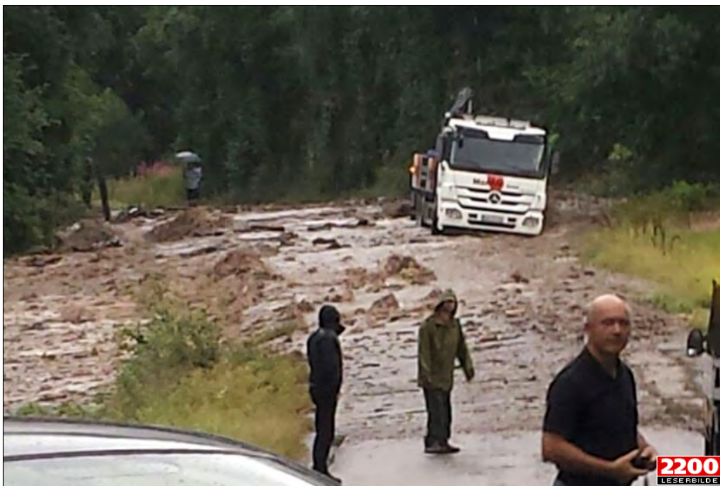
Figur 5.8: Flommen i august 2013: Noen steder ble veien vasket helt vekk. Her er veien mellom Bø og Notodden. (Kilde: www.vg.no 06.08.2013. Foto: Elin Kambestad Raukleiv)
