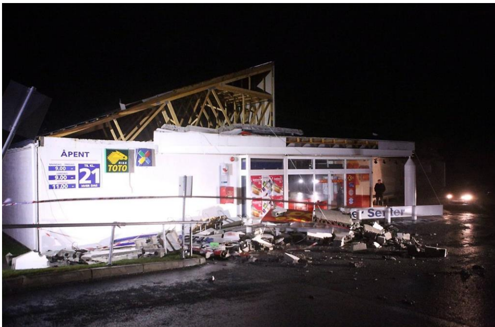
Figur 16: Vikhammersenteret i Malvik fikk store skader av ekstremveret «Ivar». Foto: Scanpix Fra: http://www.tu.no/it/2013/12/16/superdatamaskinen-vilje-oppdaget-ivar-i-siste-liten
