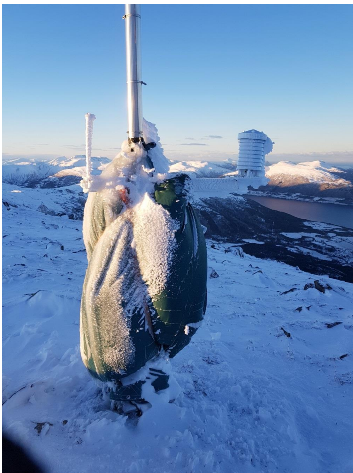
Figur 13. Skapene innpakket for lettere tilgang om vinteren når alt under 2 m er isdekket.
