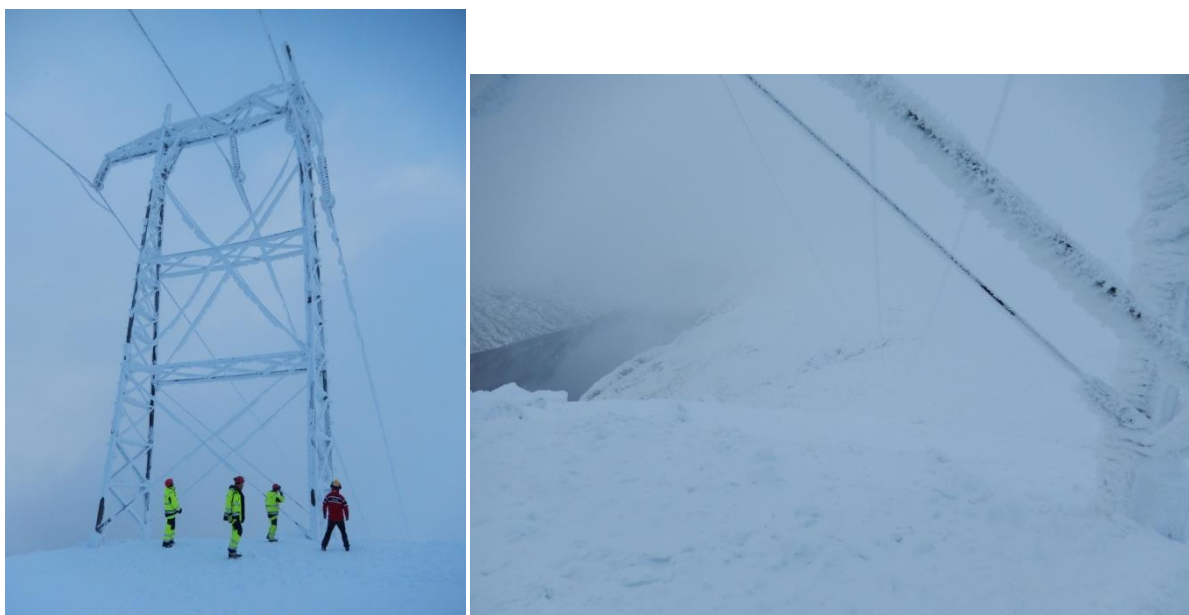
Figur 2-2 Bilder fra mast 40, tatt under befaring den 20.11.2014. Isens form på bildet til høyre viser at isen har bygget seg på ved vind fra øst. Begge bildene er tatt i retning øst (mot høyere mastenummer). Foto: Statnett.
