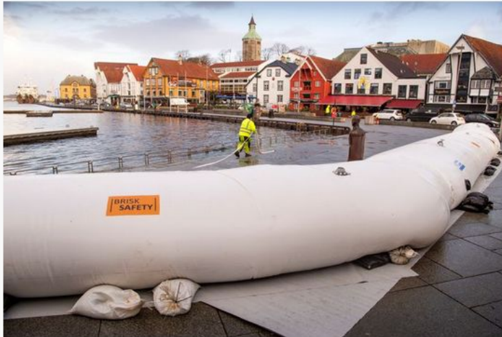
Denne flomsperren på 110 meter rommet 99.000 liter vann, og skal polstre Vågen mot ekstremværet Didrik. Foto: Fredrik Refvem
