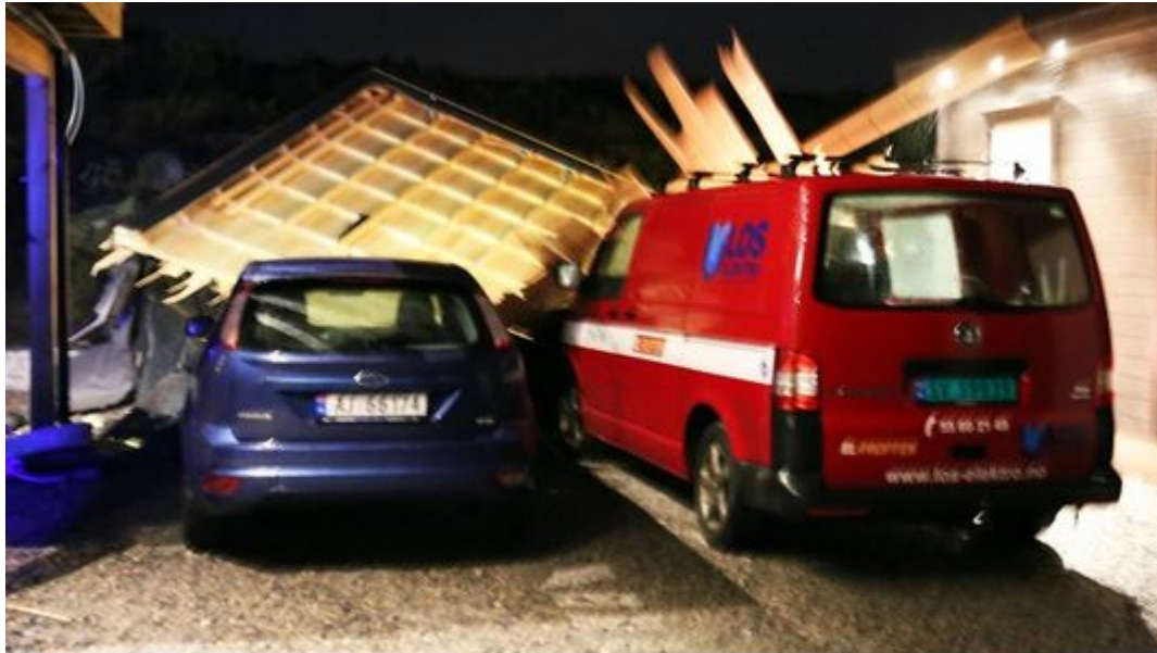
Figur 5: Nedblåst tak over bilar på Sotra. Bilete frå Nrk.no. Taket var feilkonstruert.
