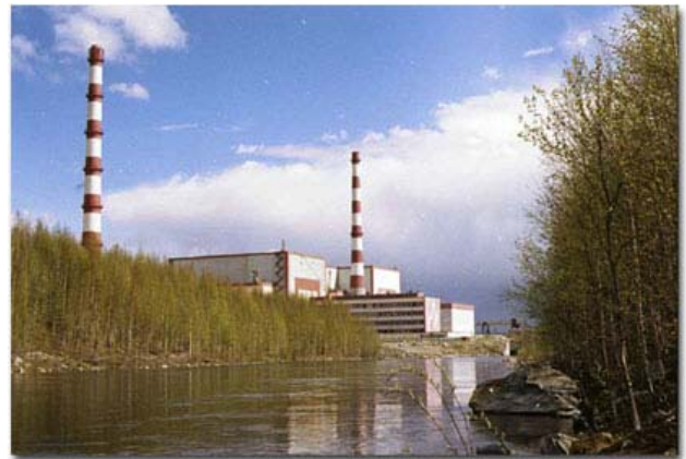
Figur 1. Utsikt mot Kola kjernekraftverk.
