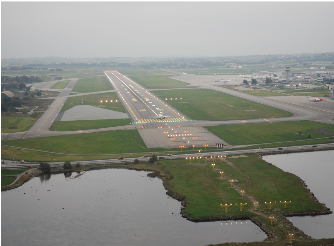
Stavanger lufthavn - Sola. Innflygning fra nord. Foto: Avinor
