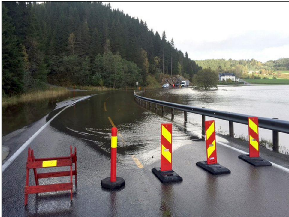
Figur 9: Flommen førte til at E6 ble stengt ved Fossland i Grong.
